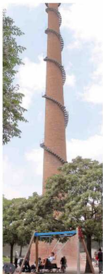
La chimenea, tras las obras.
